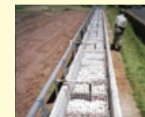
湖沼に流れ込む生活排水の浄化実験 (千葉県柏市) 平成11年3月～平成15年7月
