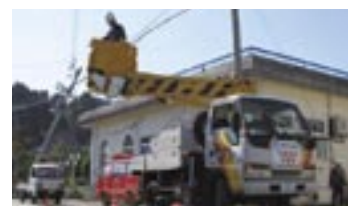
通信ケーブルの応急復旧
