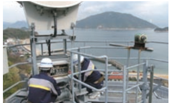
無線伝送装置の点検作業
