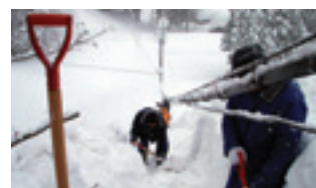
4m近い記録的な積雪となった上越・南魚沼エリアでのケーブル掘り出し作業
