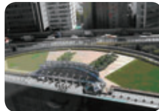
初台ビルの屋上緑化(NTT東日本)
