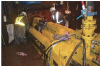
河川の下越しに管路を新設し、中継ケーブルを敷設する様子
