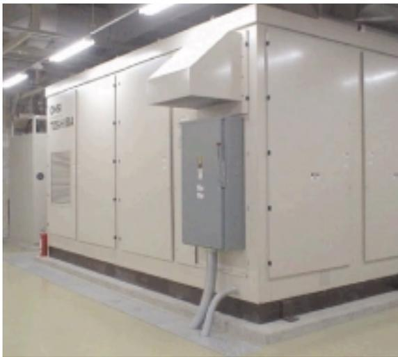
写真4.2-4 マルチ燃料型燃料電池
