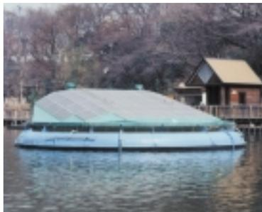
写真4.2-2 水浄化用太陽光発電システム
