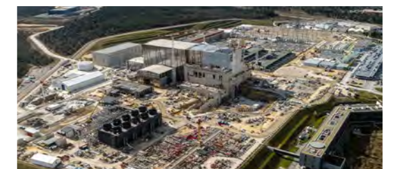
南フランス・プロバンスに建設中の全体図
