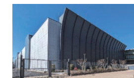
NTTデータ三鷹データセンターEAST:2025年度中にPPA・非化石証書等の手法通じて使用電力を実質的な再生可能エネルギー100%に転換
