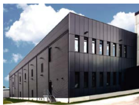
「ドイツ ライン・ルール1 データセンター」を提供開始
