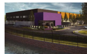
「バージニア アッシュバーン3 (VA3) データセンター」を提供開始およびVA4データセンターを建設開始
