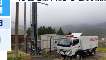
（移動電源車による電力供給）
