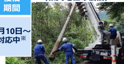
（被災電柱の復旧）
