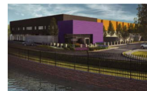
「バージニア アッシュバーン3 (VA3) データセンター」を提供開始およびVA4データセンターを建設開始
