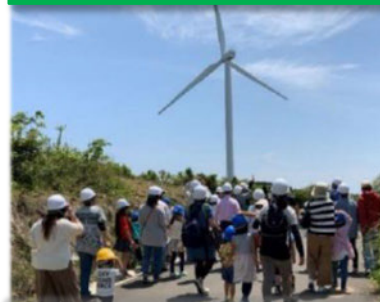
発電所の一般公開※ (高知県大月町)
