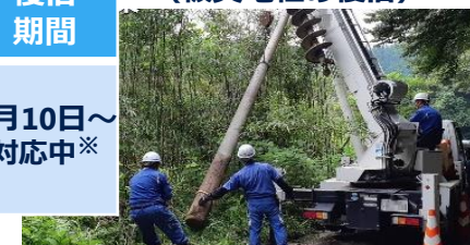
（被災電柱の復旧）
