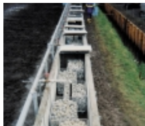
図4.4-6 フィールド試験でのMPM設置状況
