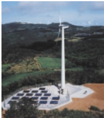
写真4.2-1 久米島ハイブリッドシステム
